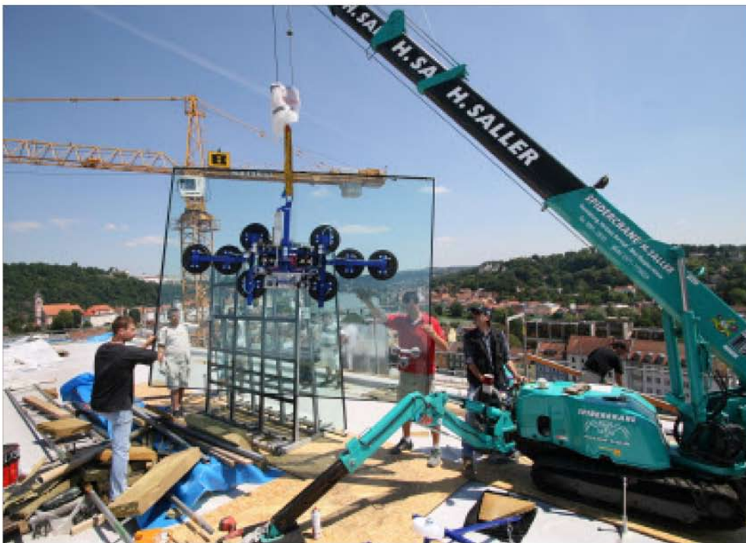
Zehn Glassauger halten die 600 Kilogramm schwere Scheibe fest, die von oben in die Fassade eingesetzt wird. Acht Mann arbeiten in 40 Metern Höhe an dem diffizilen Auftrag auf dem KVV-Turm. (Fotos: Jäger)
