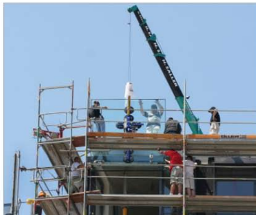
Vorsichtig muss die Glasscheibe heruntergelassen werden – die Millimeterarbeit wäre mit einem konventionellen Kran von unten nicht möglich.
